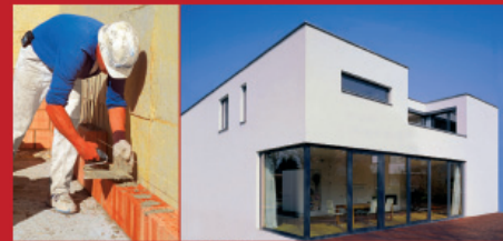
Zweischalenmauerwerk (Lehmsteine)
